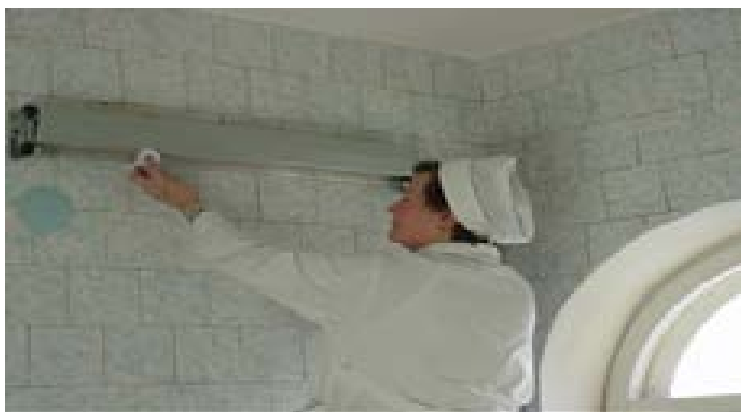
рис.2 - Очистка БУФ ламп 6
